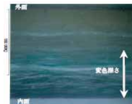
写真1. 塩酸環境で使用したFRP断面 (黒色への変色が内面側より層状に進行している)
